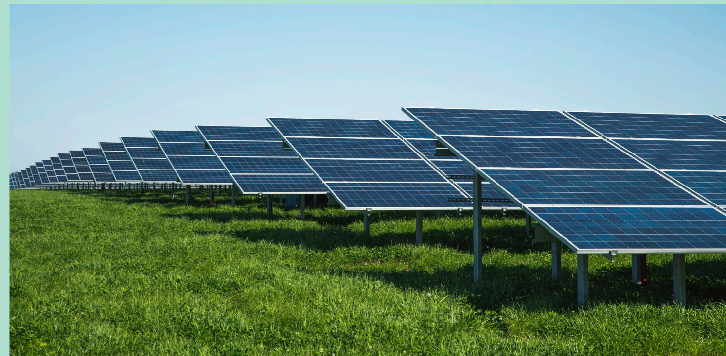
Sådan kan et solcelleanlæg se ud. Foto: Better Energy.
