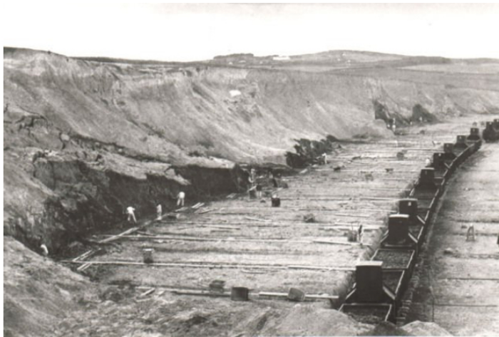
Al arbejde foregik ved håndkraft. Merglen blev med skovl læsset på trillebør og derefter kørt op på togvognen
